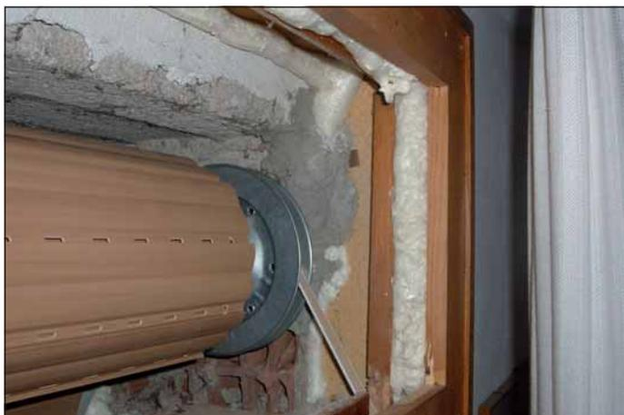
Esempio di applicazione pratica di ristrutturazione di un serramento con avvolgibile.
