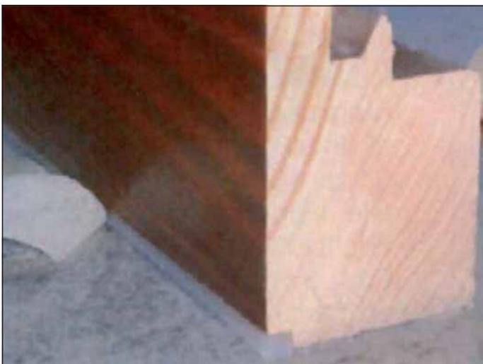
Siliconatura dello scuretto traverso inferiore del telaio.
