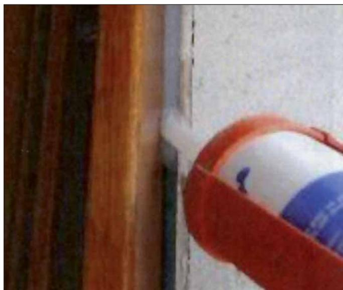
Controllo della sigillatura perimetrale tra falso telaio e telaio esterno.
