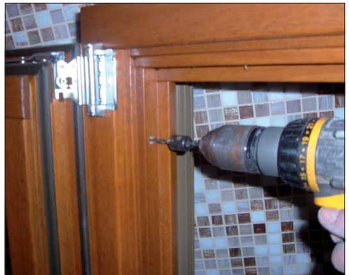
*Preforatura del telaio.*
