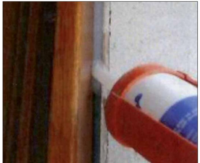
Controllo della sigillatura perimetrale tra falso telaio e telaio esterno.
