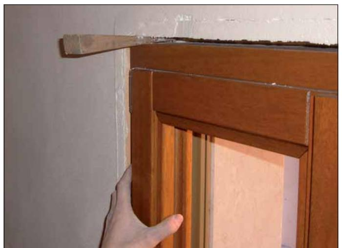
Posizionamento e fissaggio con chignoli in legno del telaio.
