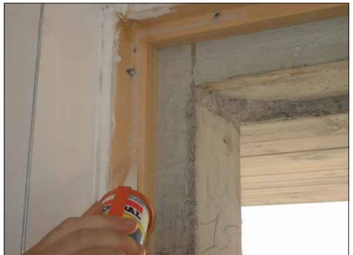
Cordolo di silicone sul perimetro del falso telaio e sul davanzale.
